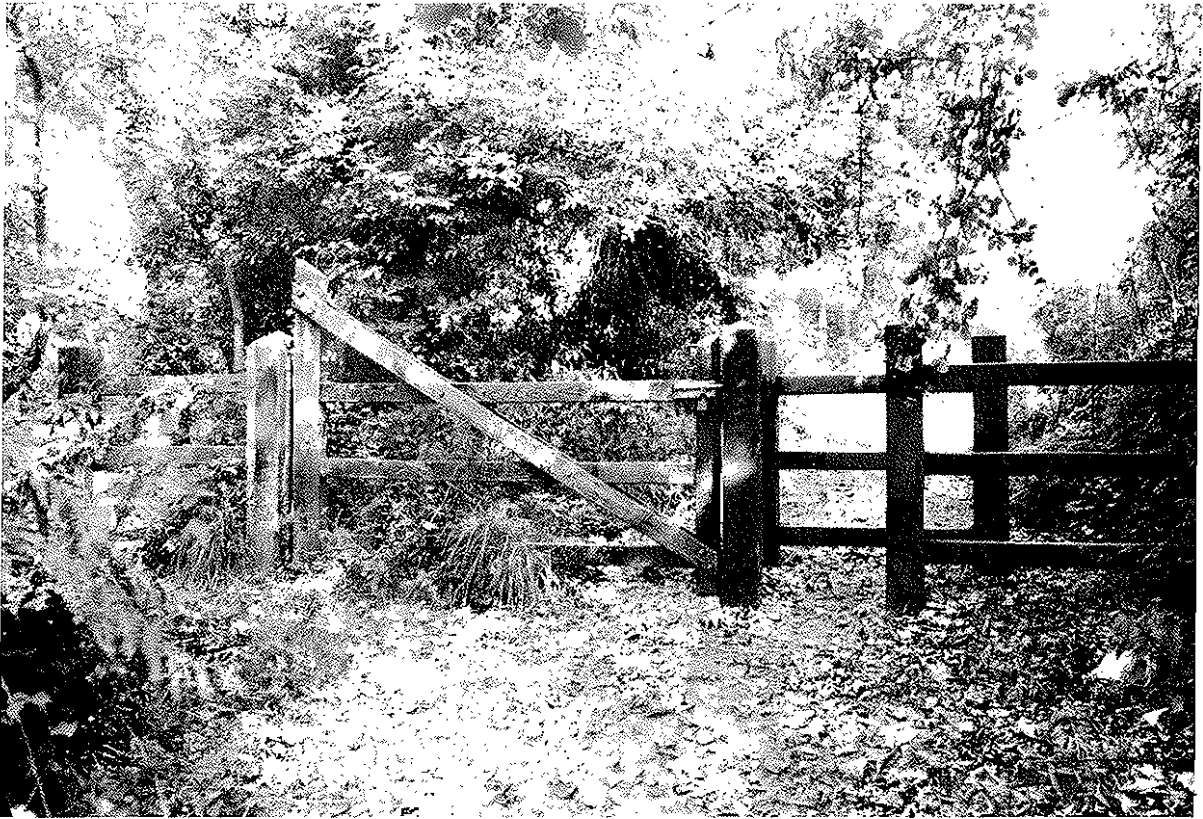
Dispositif anti-motos avec barrière pour l'exploitant agricole
