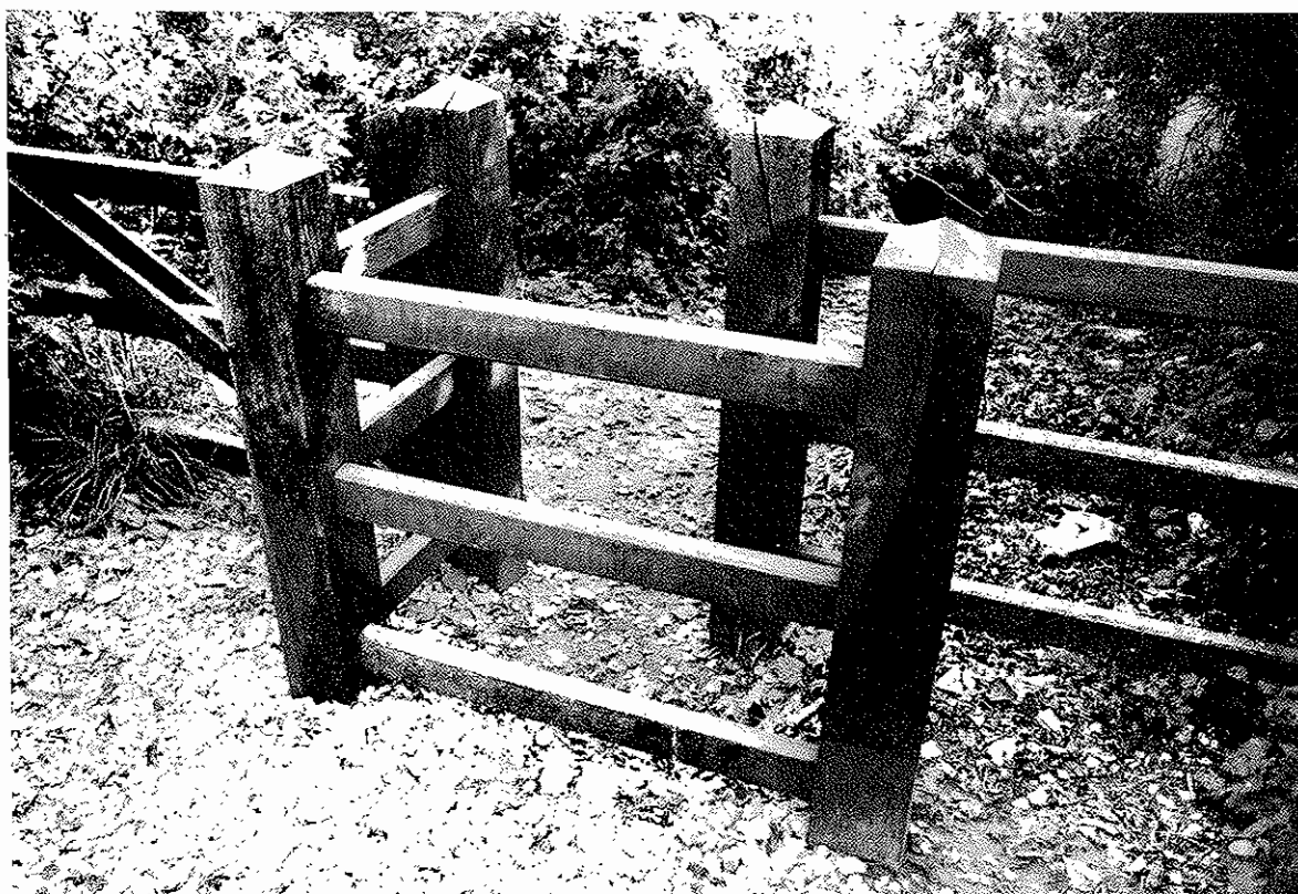
Chicane permettant le passage des promeneurs tout en évitant la divagation des animaux
